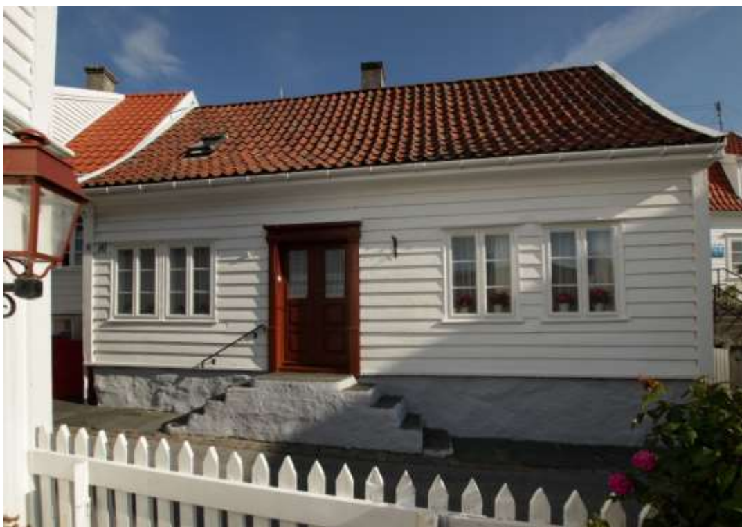
Figur 3. Skudeneshavn. Søragedå 26, Sett fra sydvest. Foto: J. Brønne. September 2016.
