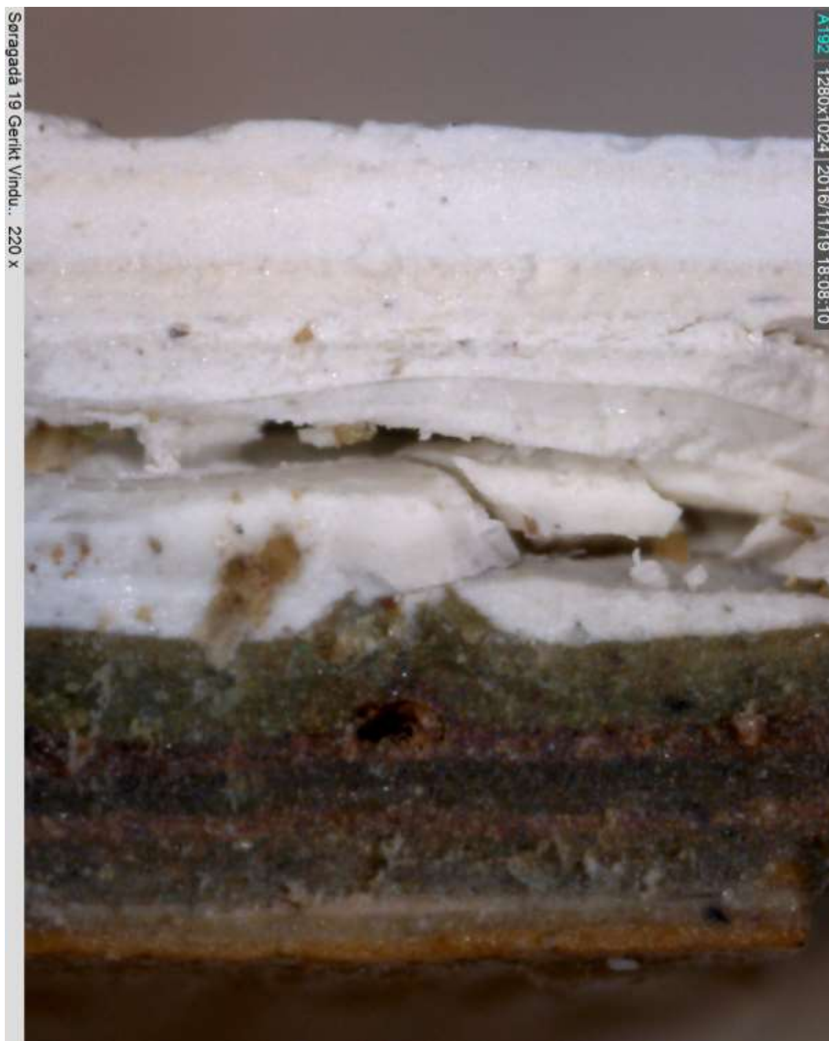
Figur 32. Skudeneshavn. Sørsgada 19. Fargesnitt av malinglagene på vindusgeriktene. Nederst sees de ni eldste malinglagene med kontrastfarger. Det er ingen malinglag som inneholder blyhvit i fargesnittet. Foto: J. Brønne. November 2016.
