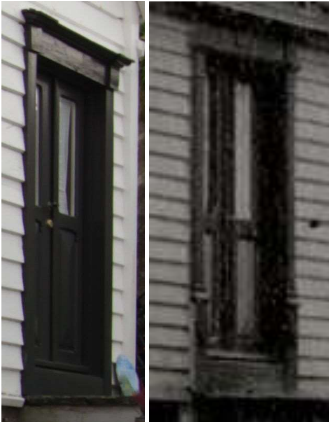
Figur 53. Søragedå 37. Til venstre, dagens dør og dørromramming i vestveggen. Foto: J. Brønne. September 2016. Til høyre, Detalj av figur 48. Foto: Ukjent. Bildet viser at dørbladene på de to dørene har likhetstrekk med hensyn til formatering, avfasinger og profiler. Men det er ikke det samme dørblad som ble flyttet til vestveggen. Glassformatene i den eldste døra var vesentlig større enn dagens dør. Den utsmykkete dørromrammingen som var på huset i 1927 ble heller ikke flyttet over til vestsiden. Dagens dør er i tillegg helt nedskrapet, så selv ved hjelp av feltmikroskop var det ikke mulig å finne sikre spor etter eldre fargestratigrafi.
