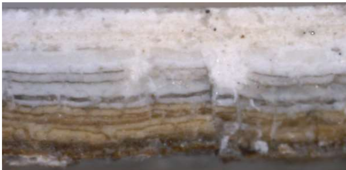
Figur 83. Skudeneshavn. Holmen 16. fargesnitt av malinglagene på panelet på hovedbygningen. De eldste sandsteinsfargete malinglagene er lett synlige. Disse lagene mangler på sidefløyens nordøstvegg. Foto: J. Brønne. November 2016.
