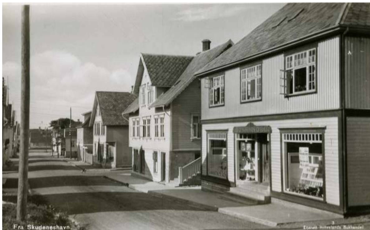
Figur 110. Skudeneshavn. Kirkevegen 18. Bokhandelen. Sett fra nordøst. De opprinnelige fargene og fargesettingen er fremdeles på bygningen. Det betyr at bildet er tatt før første overmaling, da den kraftige kontrastfargen ble overmalt med hvit. Det er dessverre ingen kjøretøy eller personer i bildet, noe som kunne ha hjulpet til en datering av bildet. Fontene i teksten er av type som ble mye benyttet i perioden ca. 1930 til 1955. Postkortet er trolig fra perioden 1930-1940. Foto: Trolig Hilleslands Bokhandel.
