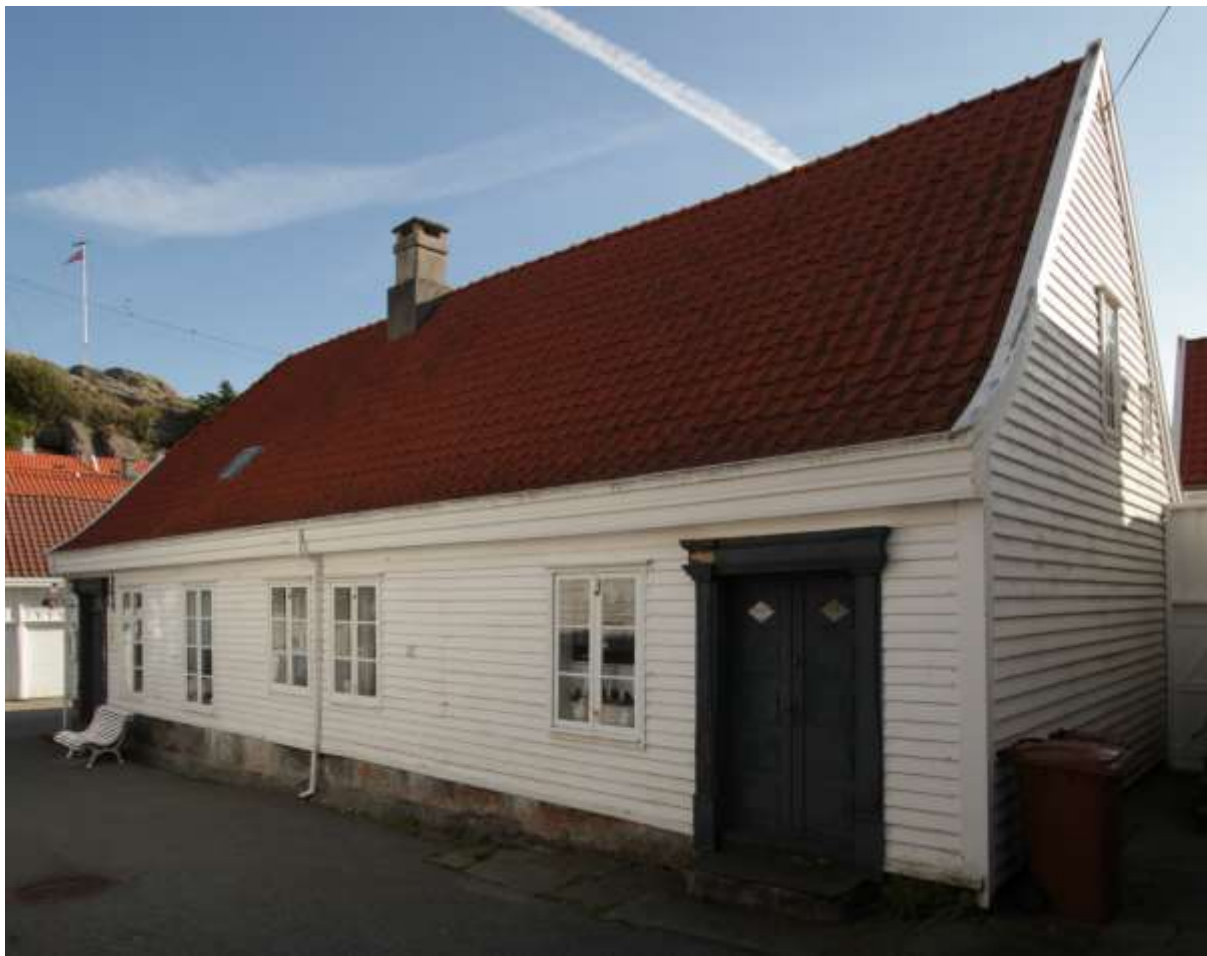
Figur 79. Skudeneshavn. Holmen 16. Hovedbygningen sett fra sydvest, med den sydligste døra. Legg merke til vindusformatene i den eldste delen av bygningen mot syd, og de større, nyere vinduene mot nord. Foto: J. Brønne. September 2016.
