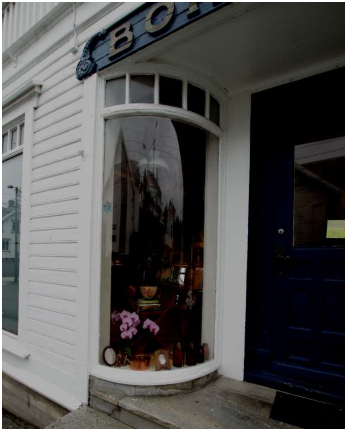
Figur 120. Skudeneshavn. Kirkevegen 18. Bokhandelen. Detalj av den søndre delen av inngangspartiet med buvinduet med jugendstilens små vinduer over hovedvinduet. Foto: J. Brønne. September 2016.
