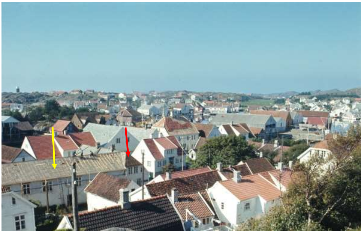
Figur 77. Skudeneshavn. Holmen 16. Sett fra øst. Bildet viser at de i 1972 la om begge takene, og det ser også ut til at panelet på sidefløyens 2. etasje ble skiftet. Hele huset var da ensfarget uten noen kontrastfarger. Foto: Ukjent. 1972.
