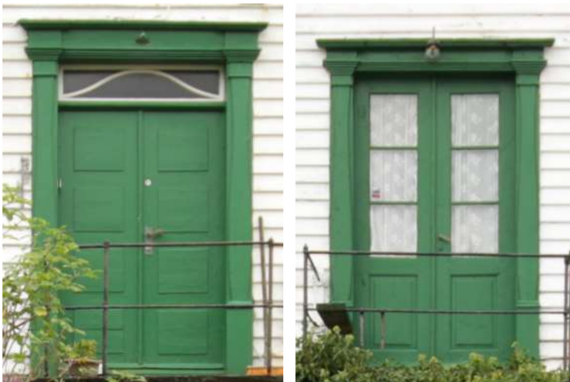
Figur 70. Holmen 5. Døra til venstre er hovedinngangsdøra mot nordøst. Tofløyet innadslående med fire kvadratiske fyllinger i hvert dørbblad. Overlys med senempire sprosseverk. Døra til høyre er sjøsidedøra. Tofløyet, innadslående dør med en fylling nede i hver dør, og tre glass i samme formater som fyllingene over nederste fylling. Begge dørene er trolig opprinnelige. Begge dørene og døromramminger er malt bladgrønne. Foto: J. Brønne. September 2016.
