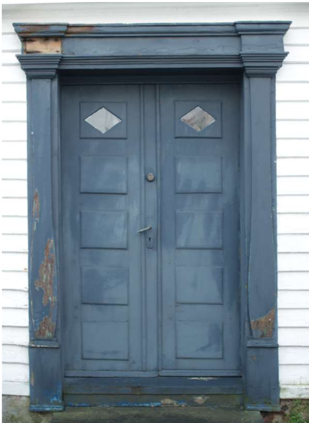
Figur 88. Skudeneshavn. Holmen 16. Døra i syd i vestveggen. Tofløyet innadslående, empire fyllingsdør med fem kvadratiske fyllinger med svakt liggende format i hvert dørblad. Kraftig profilert gesims i overstykket. Svungne utsveifete, senempire pilastre i sideomrammingene. Døra har ikke overlys, så for å få litt lys inn i gangen innenfor, er det satt inn rombformete glass i de to øverste fyllingene. Foto: J. Brønne. September 2016.
