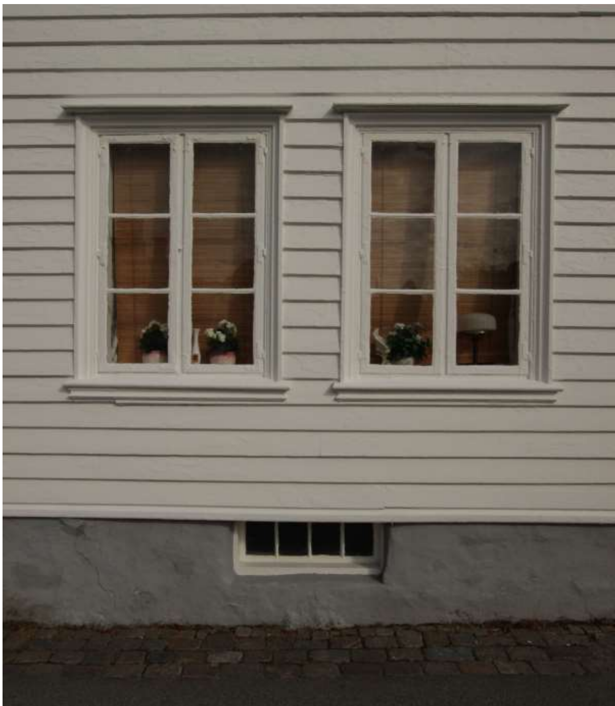
Figur 13. Skudeneshavn. Søragadå 18, sett fra sydvest. Profilert supanel. To rams sidehengslete empirevinduer med originale beslag og gerikter. Panel, vinduer og gerikter er opprinnelige. Foto: J. Brønne. September 2016.
