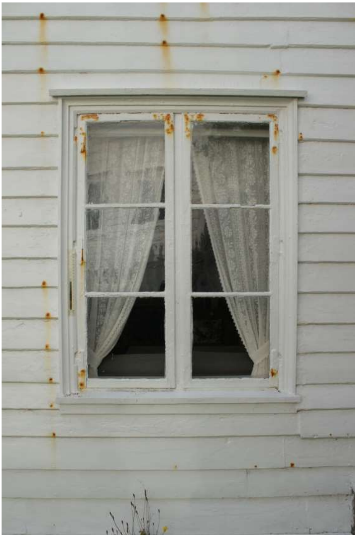
Figur 25. Skudeneshavn. Søragedå 19. Opprinnelig torams sidehengslet empirevindu med originale beslag og gerikter. Gavlveggen mot Søragedå. Foto: J. Brønne. September 2016.
