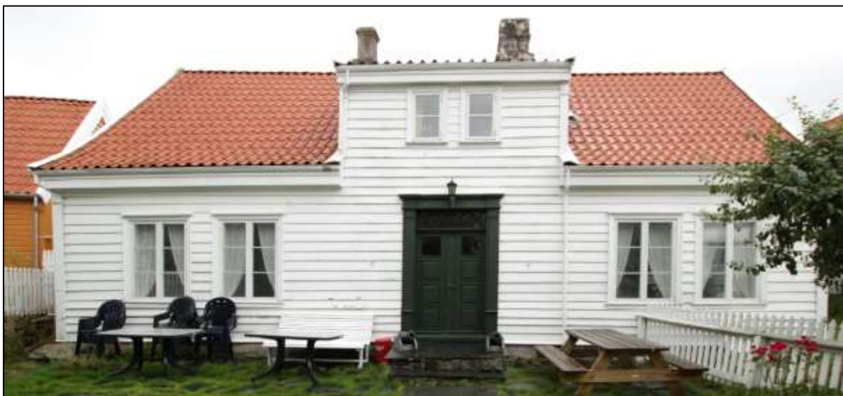
Figur 23. Skudeneshavn. Søragedå 19. Hovedfasaden mot sydøst. Profilert supanel. Torams sidehengslete empirevinduer med originale beslag og gerikter. Panel, dørromramming, vinduer og gerikter er trolig opprinnelige. Hoveddøra er ny. Foto: J. Brønne. September 2016.
