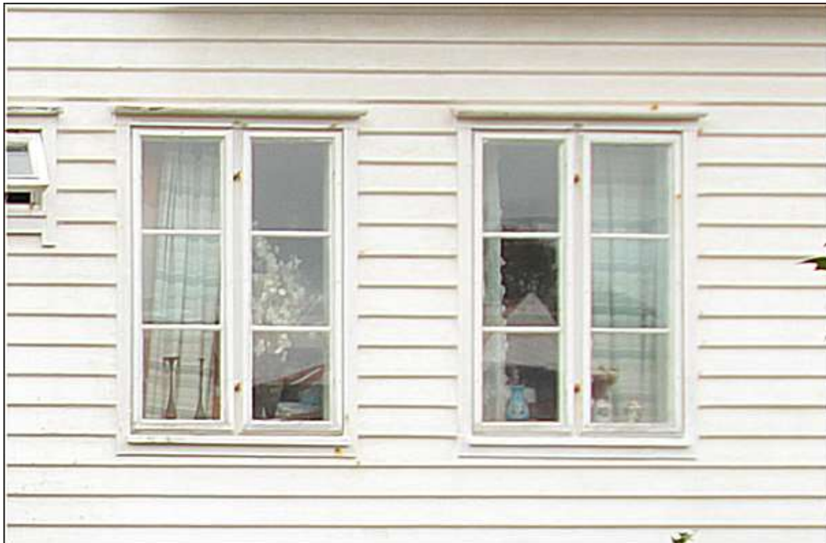
Figur 72. Holmen 5. Som på mange andre hus i Skudeneshavn, er det montert utvendige dobbelt/vare/isolasjonsvinduer på originalvinduene. Dette innebærer at det ikke var mulig å utføre undersøkelsene ved å lage stratigrafiske fargelagsavdekkinger. Undersøkelsene av vinduene er utført ved hjelp av feltmikroskop og fargesnittsprøver. Foto: J. Brønne. September 2016.
