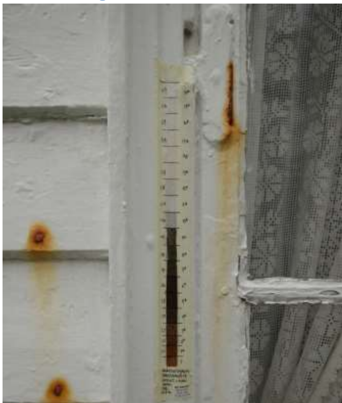
Figur 31. Skudeneshavn. Søragedå 19. Fargelagsavdekking på vindusgerikt. Foto: J. Brønne. September 2016.
