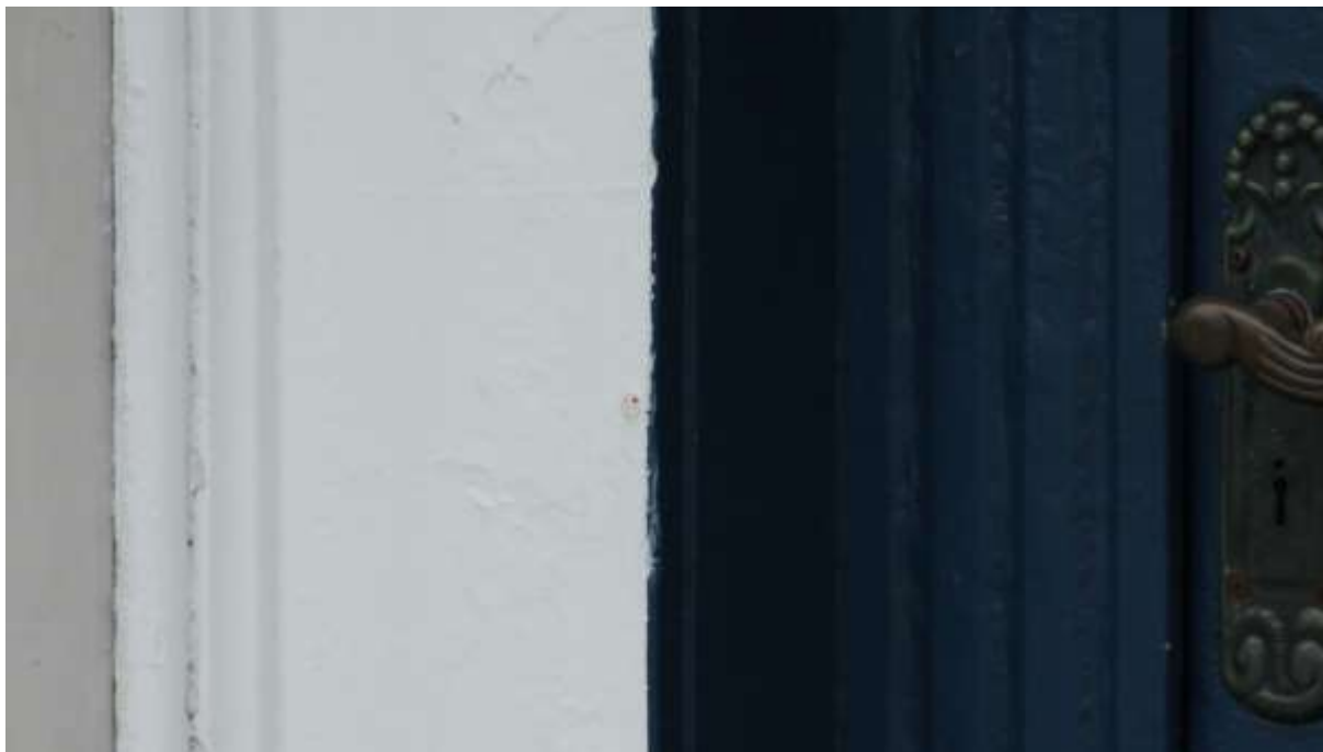
Figur 122. Skudeneshavn. Kirkevegen 18. Bokhandelen. Detalj av den søndre delen av inngangspartiet med den opprinnelige nybarokk II dørvrideren og nøkkelskiltet, kanelert gerikt og dørkarmen. Foto: J. Brønne. September 2016.
