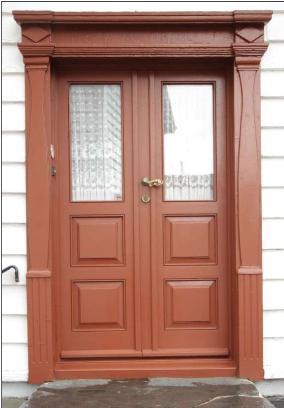
Figur 42. Skudeneshavn. Søragedå 26. Hoveddøra. Dørbladene er nye. Karm og omramming er de opprinnelige. Dessverre var disse elementene så nedbrutt og nedskrapet at det ikke var mulig å undersøke disse med fargelagsavdekkinger. Alle undersøkelser på døromrammingen er utført ved hjelp av feltmikroskop. Foto: J. Brønne. September 2016.
