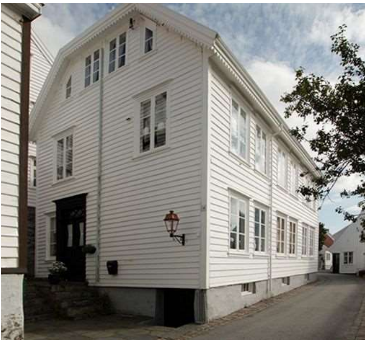
Figur 12. Skudeneshavn. Søragedå 18, sett fra vest. Panel, hoveddør, vinduer og gerikter er opprinnelige. Foto: J. Brønne. September 2016.
