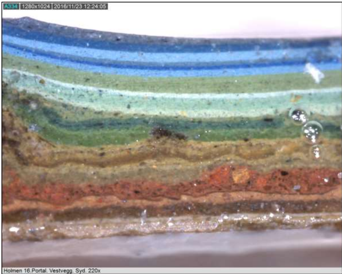
Figur 87. Skudeneshavn. Holmen 16. Fargesnitt av malinglagene på døra mot syd i vestveggen og dørromrammingene på vestveggen, viser at fargeleden og variasjoner i farger har vært stor på dørene og dørromrammingene på Holmen 16 gjennom historien. Foto: J. Brønne. November 2016.
