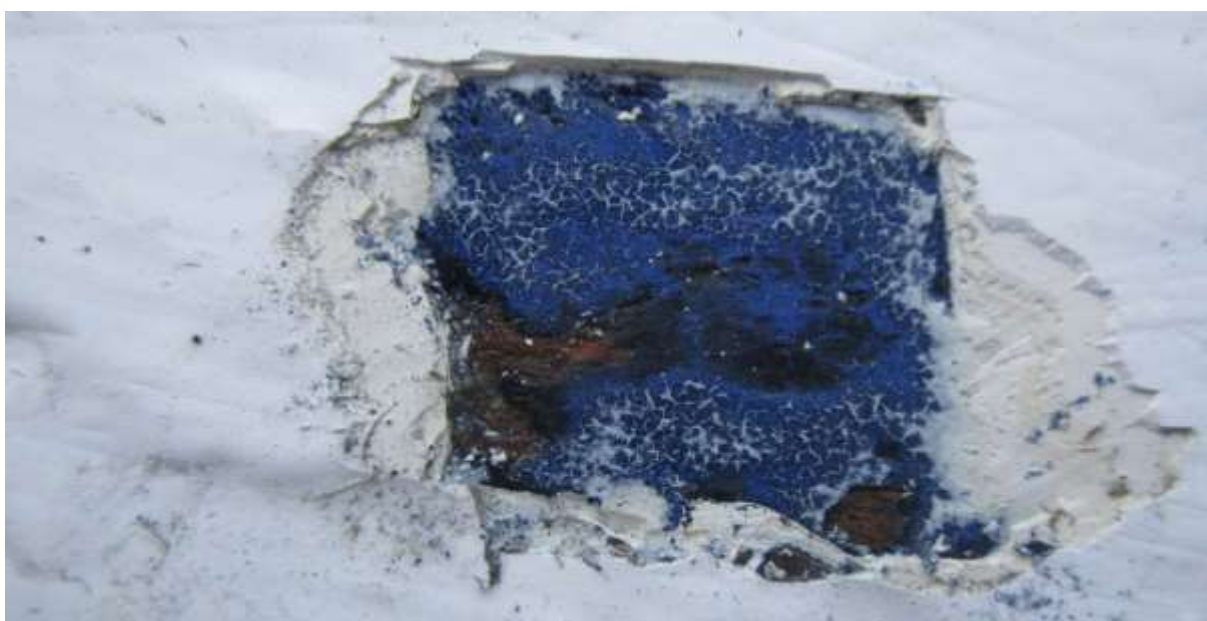
Figur 123. Skudeneshavn. Kirkevegen 18. Bokhandelen. Makrofoto av avdekkingsprøve som viser det opprinnelige malinglaget med en mørk grunning og den opprinnelige blå fargen. Foto: J. Brønne. September 2016.
