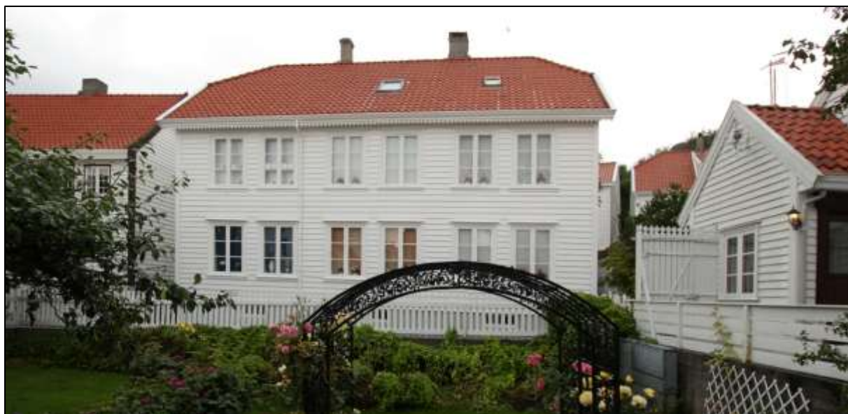
Figur 11. Skudeneshavn. Søragedå 18, sett fra sydvest. Panel, vinduer og gerikter er opprinnelige. Foto: J. Brønne. September 2016.
