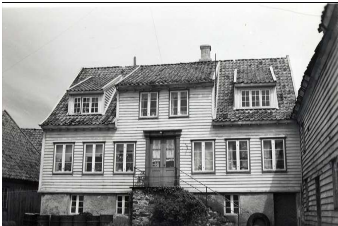
Figur 63. Holmen 5. Sett fra sydvest. Profilert supanel, torams empirevinduer med tre glass i hver ramme, hengslet på midtposten. Glasset er i store, stående formater. Tofløyet, innadslående dør med en fylling nede i hver dør, og tre glass i samme formater som fyllingene over nederste fylling. Sekundære arker i takflaten. Kontrastfarger på vindusgerikter, dør og døromramming. Eldre udatert bilde. Foto: Ukjent.
