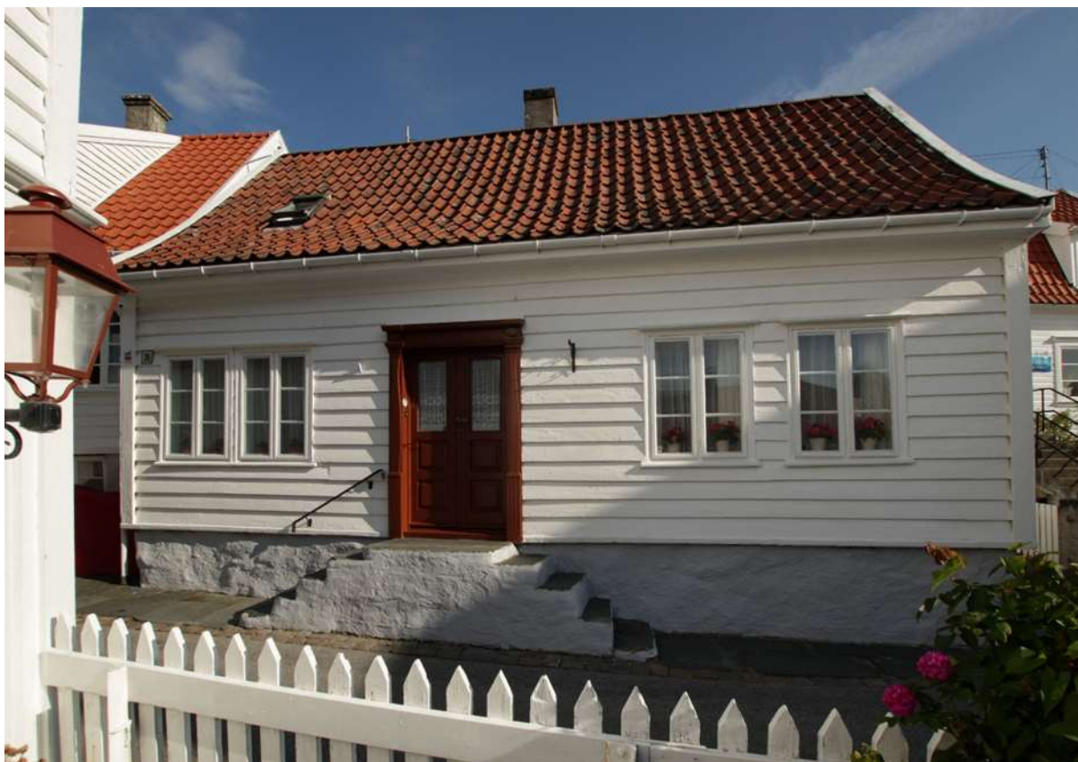
Figur 40. Skudeneshavn. Søragedå 26. Sett fra syd. Fargesettingen er fremdeles som den var i 1974, men det ser ut til at fargen på døra og dørromrammingen er noe lysere og rødere enn fargen fra 1974. Vinduene i døra er utvidet, og inkluderer nå også den øverste fyllingen. Se figur 34. Foto: J. Brønne. September 2016.
