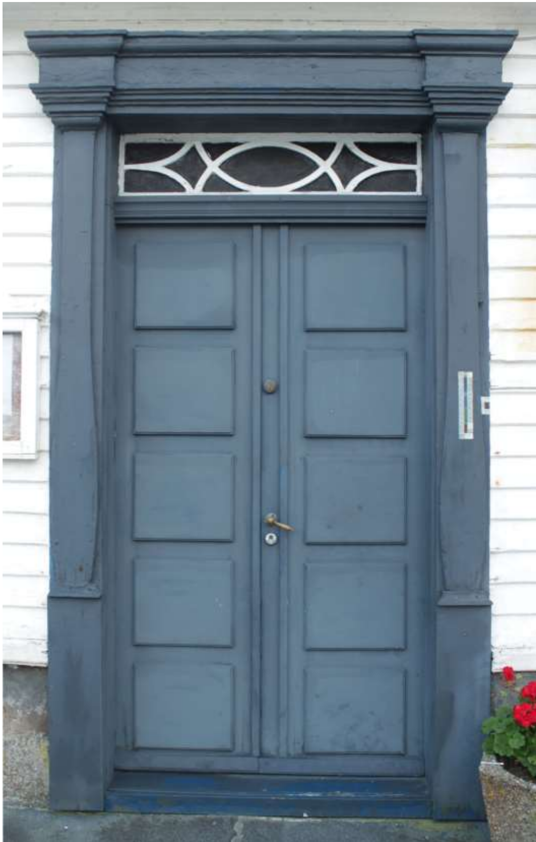
Figur 85. Skudeneshavn. Holmen 16. Hoveddøra i nordvestveggen. Ny. Trolig kopi av den opprinnelige døra. Tofløyet innadslående, empire fyllingsdør med fem kvadratiske fyllinger i hvert dørblad. Kraftig profilert gesims i overstykket. Svungne utsveifete, senempire pilastre i sideomrammingene. Empire overlysvindu med svungne sprosser. Foto: J. Brønne. September 2016.
