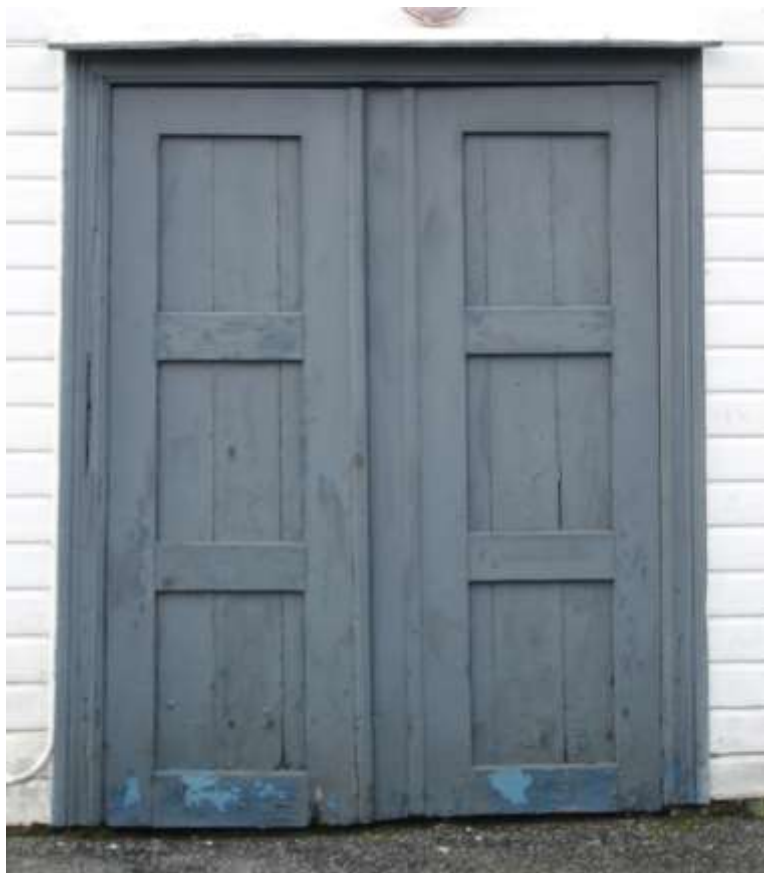
Figur 90. Skudeneshavn. Holmen 16. Dør B. Tofløy, innadslående labankdør, med påsatte «ramtrær» på utsiden som lager tre fyllinger i stående format. Profilerte sveitserstilsgerikter. Foto: J. Brønne. September 2016.
