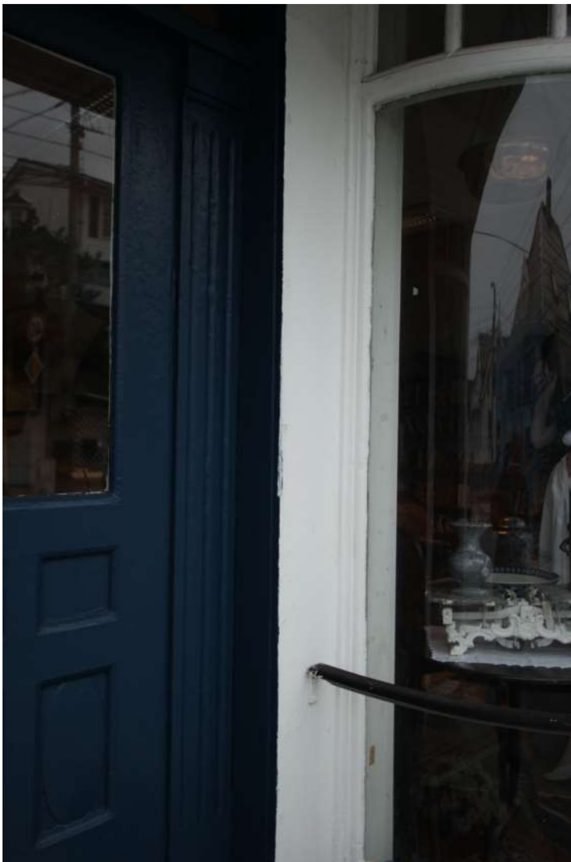
Figur 121. Skudeneshavn. Kirkevegen 18. Bokhandelen. Detalj av den nordre delen av inngangspartiet, med nyklassisistiske, konkavt kannelerte dørgerikter. Foto: J. Brønne. September 2016.
