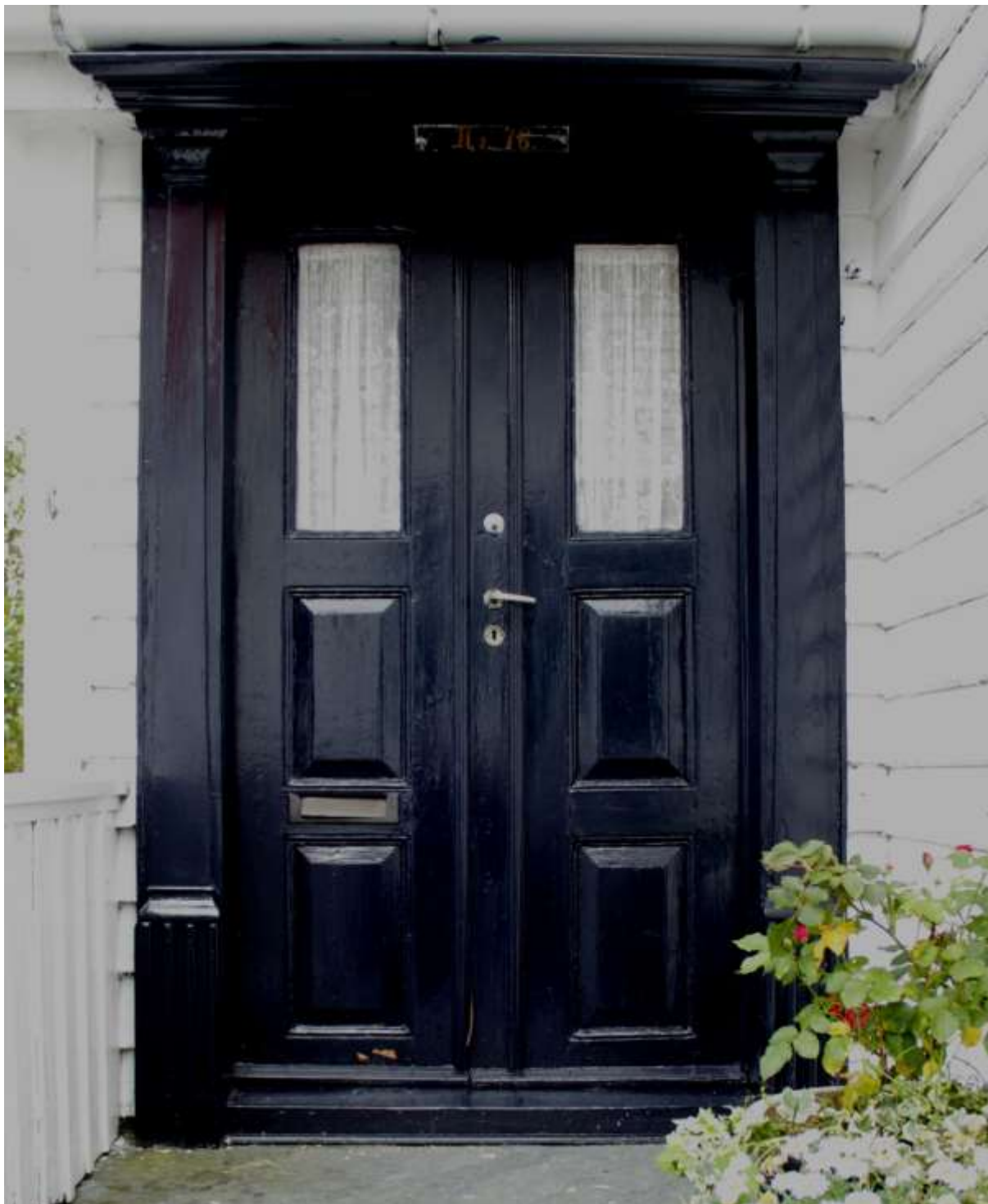
Figur 103. Skudeneshavn. Gunnarsbakken 5. Hoveddøra. En meget flott og vakkert utformet Senempire innadslående, tofløyet, trefyllingsdør. Øverste fyllinger er erstattet av glass. Dette er originalt. De nedre fyllingene har stående format, med kraftige, barokkinspirerte fyllinger med overhøyde på speilene og kraftig skrådde friser. Sidegeriktene er utformet som flate pilastre, med baser med konvekse kanneleringer. Overstykket er en meget rikt profilert, barokkinspirert gesims. Døra er så stor og forseggjort, at den trolig er sekundær i huset. Mest sannsynlig har huset hatt en vesentlig enklere dør, som trolig har stått montert i gavlveggen der hvor tilbygget nå står. Foto: J. Brønne. September 2016.
