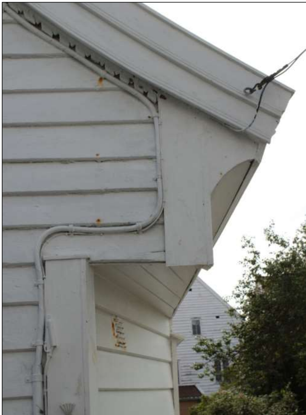
Figur 26. Skudeneshavn. Søragedå 19. Nordvesthjørnet. Hjørnet er avkuttet for å etablere god passasje til gårdene som ligger innenfor. Vakker «Kinavipp» på taket og vindskiene. Sjelden variant av løpelist under vindskiene med renessanseprofiler. Foto: J. Brønne. September 2016.
