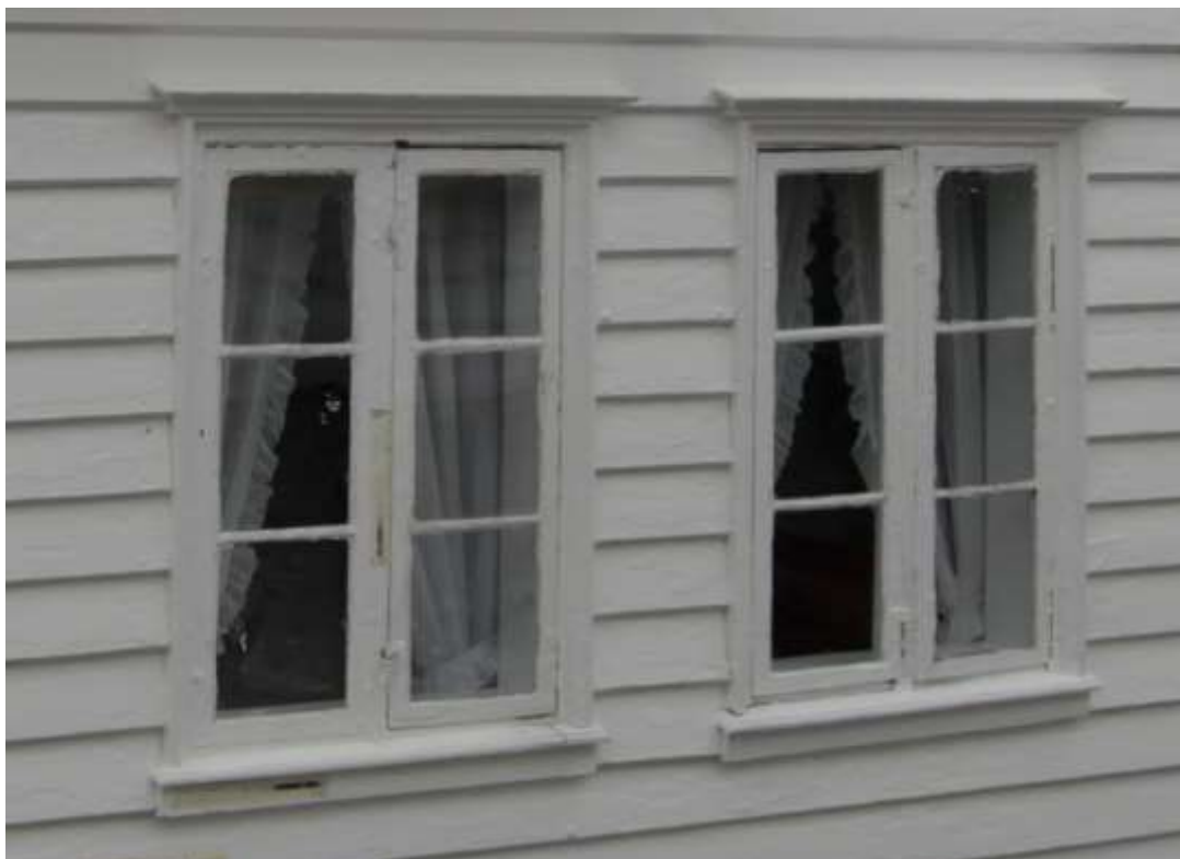
Figur 105. Skudeneshavn. Gunnarsbakken 5. Torams senempirevinduer med tre glass i hver ramme. En fastramme, og en ramme hengslet på midtposten. Senempire vindusgerikter. Foto: J. Brønne. November 2016.
