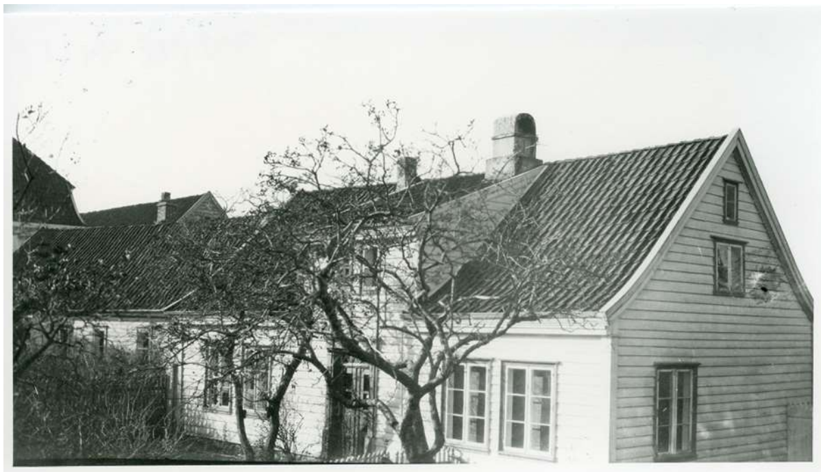
Figur 20. Skudeneshavn. Søragedå 19. Sett fra nordøst. Det ser ut til at det kun er kontrastfarger på vindusgeriktene, døromrammingen og hoveddøra. Foto: Ukjent, ingen datering.
