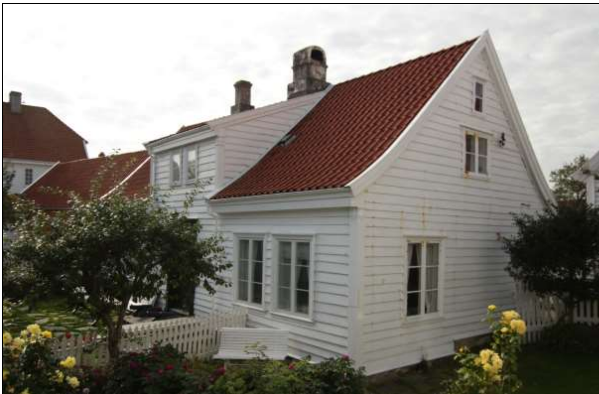
Figur 22. Skudeneshavn. Søragedå 19. Sett fra nordøst. Foto: J. Brønne. September 2016.
