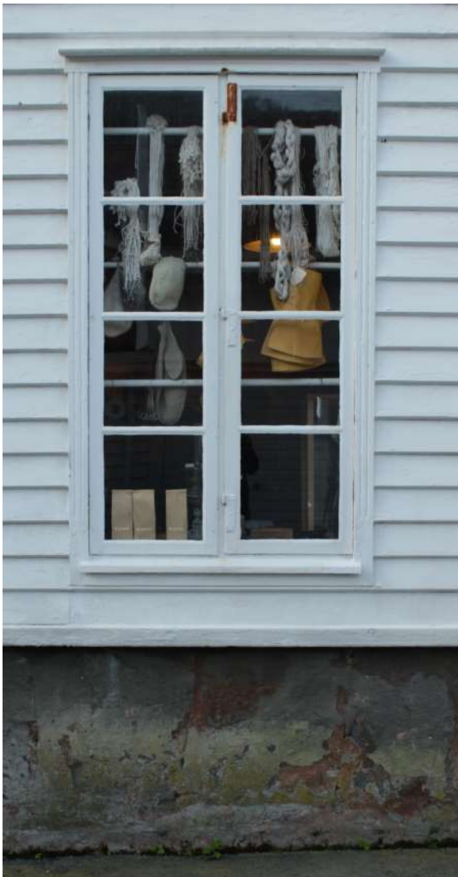
Figur 91. Skudeneshavn. Holmen 16. Torams empirevindu, med en fastramme og en hengslet på midtposten. Fire glass i tilnærmet kvadratisk format i hver ramme. Opprinnelige beslag. Side- og toppgeriktene har doble konkave kanneleringer. Foto: J. Brønne. September 2016.
