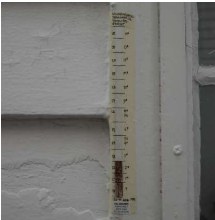
Figur 44. Skudeneshavn. Søragedå 26. Fargelagsavdekking på vindusgerikt. Utenpåliggende varevindu til høyre. Foto: J. Bræne. September 2016.
