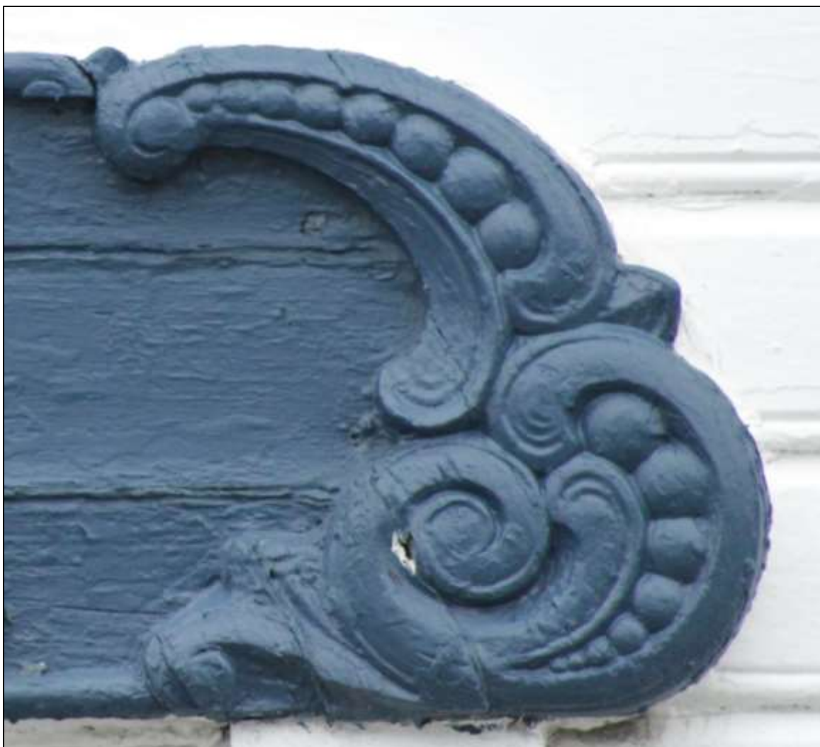
Figur 116. Skudeneshavn. Kirkevegen 18. Bokhandelen. Skåret avslutning mot nord av dekor og tekstfeltet over hovedinngangsdøra. Nybarokk II med innslag av Nyrokocco. Dekoren er sikkert skåret og har meget høy kvalitet. Foto: J. Brønne. September 2016.
