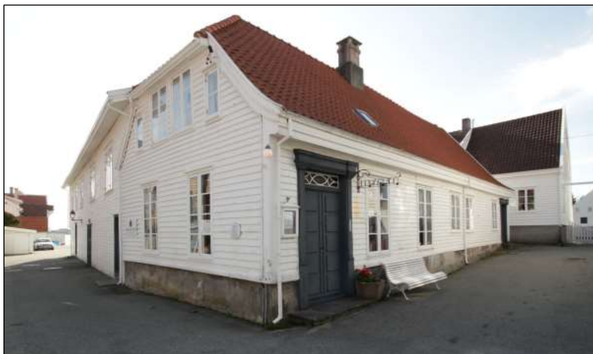
Figur 78. Skudeneshavn. Holmen 16. Hovedbygningen sett fra nord. Dørene i huset er de eneste bygningselementene som er skilt ut i kontrastfarge. Foto: J. Brønne. September 2016.
