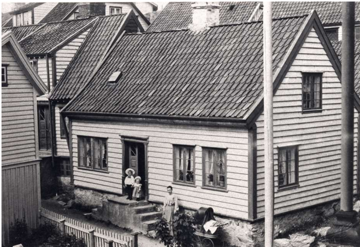
Figur 34. Skudeneshavn. Søragedå 26. Sett fra syd. Profilert supanel. Panelet er lyst, trolig hvit. Både vinduer og vindusgerikter er mørke. Det samme er laftekasser, gesims, vindskier, vannbord og sokkellist. Døra er en innadslående tofløyet fyllingsdør. Det er tre kvadratiske fyllinger i nedre del. Den øverste fyllingen er erstattet med glass. Dette er med stor sannsynlighet opprinnelig, idet det var eneste mulighet for å få lys inn i gangen. Foto: Ukjent. Trolig 1905-1910.
