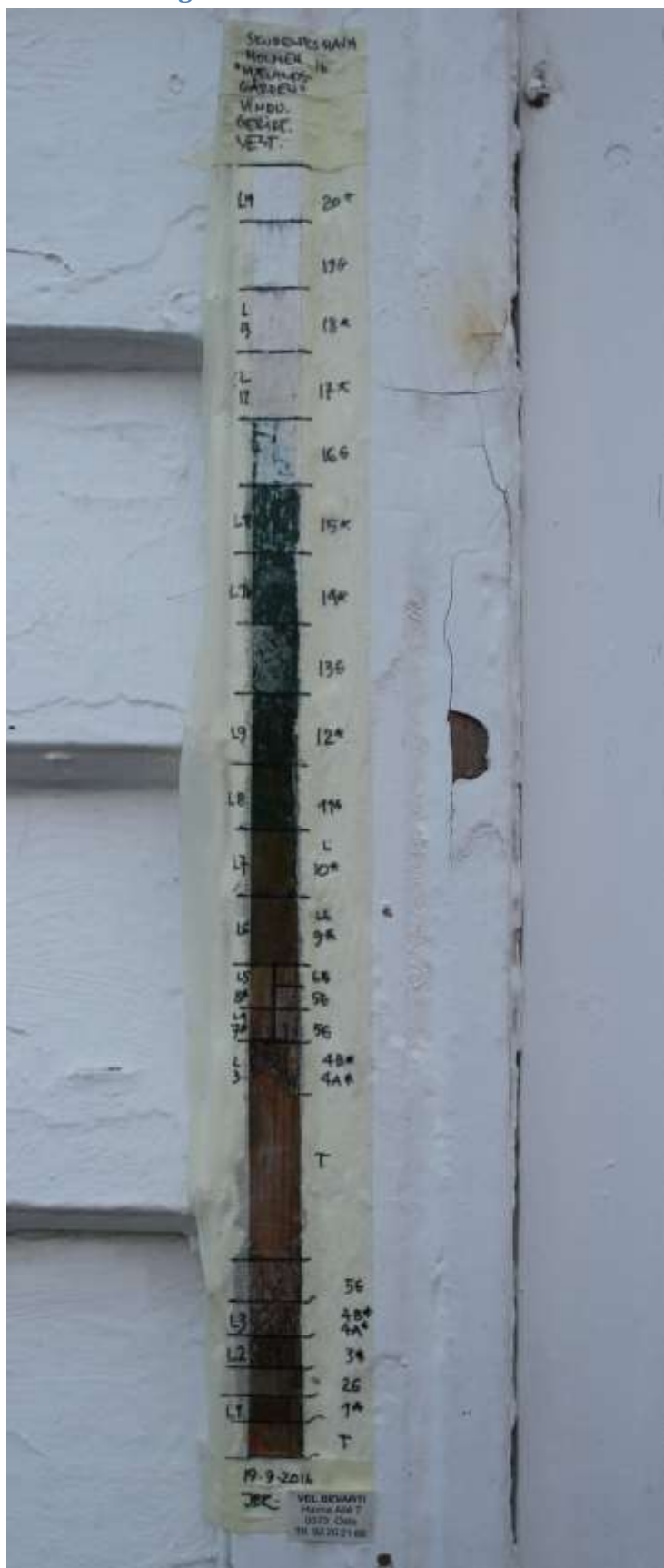
Figur 95. Skudeneshavn. Holmen 16. fargelagsavdekking på vindusgeriktene. Lagene 5G og 6G er feiltolket og derfor feilmerket. Det er avsluttende lag, og skulle derfor hatt betegnelsen L5 og L6. Se tabellen under. Foto: J. Brønne. September 2016.
