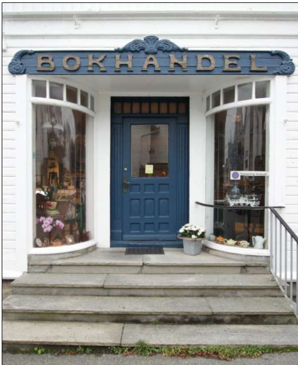
Figur 114. Skudeneshavn. Kirkevegen 18. Bokhandelen. Det meget flotte og vakkert utformede inngangspartiet med det skårne og utsveifete tekstfeltet over hoveddøra. Hoveddøra har en uvanlig utforming, med 3 x 3 fyllinger i nedre del av døra. Den midtre rekken med fyllinger har rokokkodetaljering i speilene. Døra har overlysvindu, med klassisismens formspråk, åtte små glass i rekke. Dørgeriktene er også preget av klassisismen, med konkave kanneleringer. Foto: J. Brønne. September 2016.
