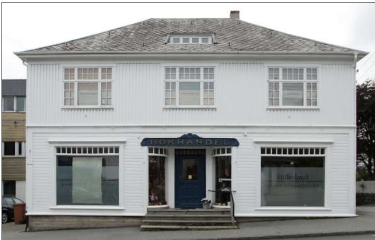
Figur 113. Skudeneshavn. Kirkevegen 18. Bokhandelen. Hovedfasaden. Sett fra øst. Liggende perlestaffspanel i 1. etasje og stående lekte/locklistpanel i 2. etasje. Den eneste endringen i fasaden er vinduet som er satt in i takflaten i loftet som erstatning for de to opprinnelige loftsvinduene. Foto: J. Brønne. September 2016.
