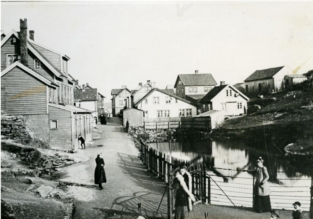
Her ser vi porten inn til verksområdet. Bygningsmiljøet som lå utenfor bestod av boliger og butikker.
