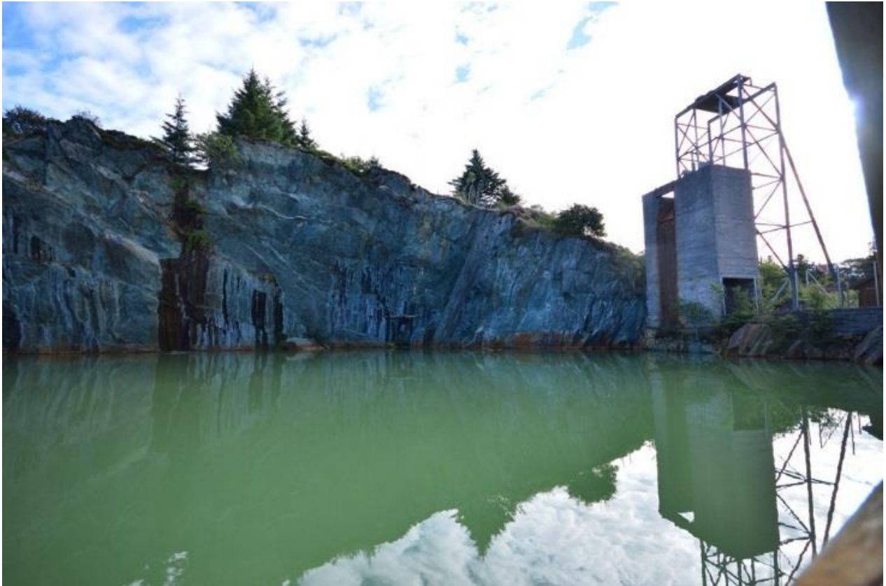
Gamlegruva er i dag fylt med vann. Til høyre sees heistårnet.
