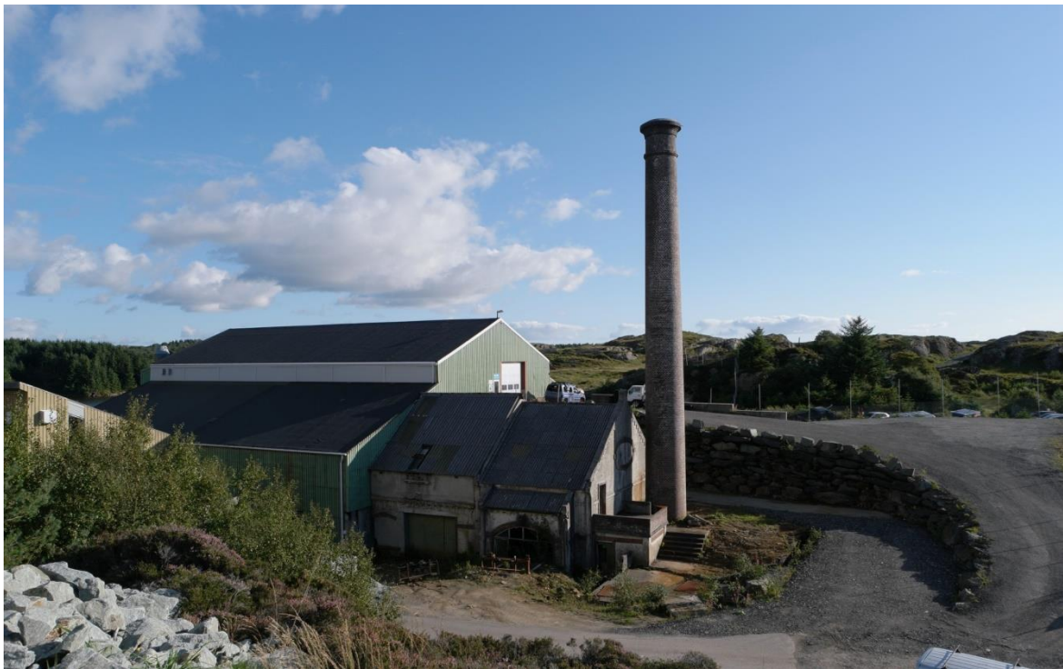
Restene etter anlegget i Rød Kleiv
